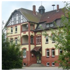
Die Schule, die Behrens seinem Heimatort stiftete, stattete er mit Heizung und einem modernen Toilettenhaus aus.
